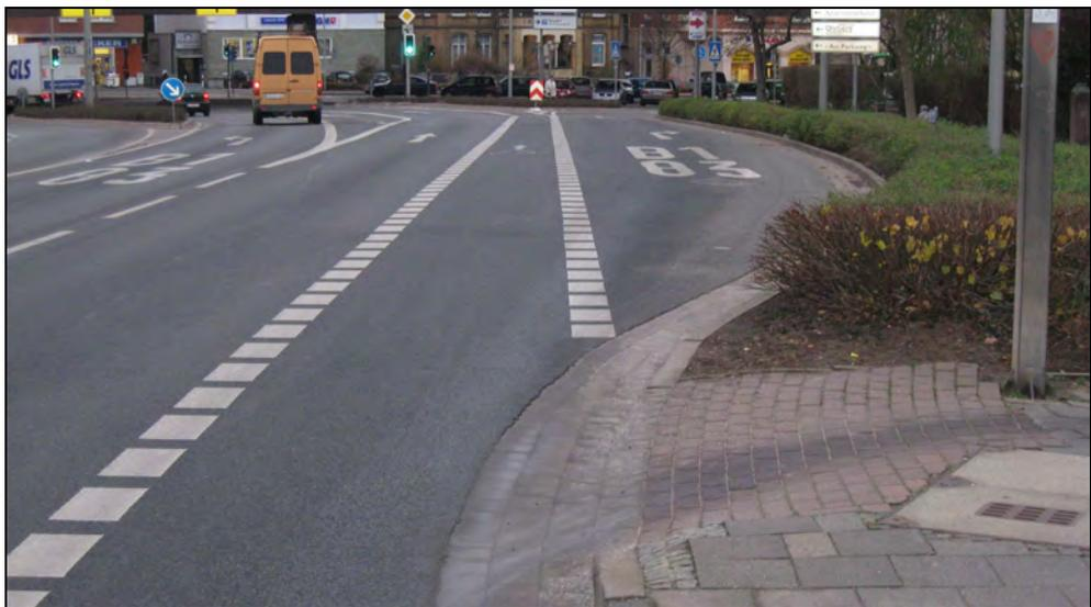
Bild 3-5 Gute Lösung: Radfahrstreifen mit eindeutiger Bevorrechtigung vor rechts abbiegenden Kfz (Brückenkopf Münsterbrücke)
