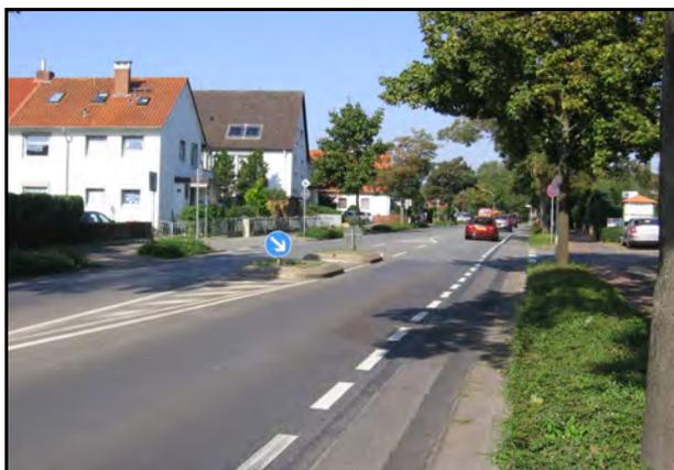
Bild 3-4 Hauptverkehrsstraße, nachgerüstet mit Mittelseln und Schutzstreifen (Reimerdeskamp, vgl. auch Anhang 6)
